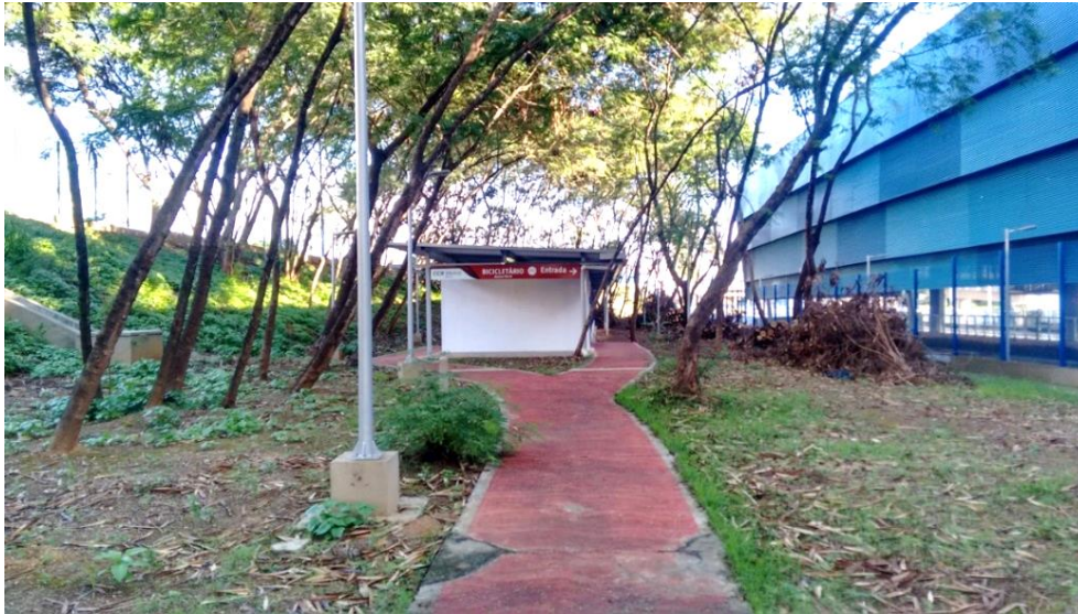
Figura 77 - Acesso ao bicicletário da estação Acesso Norte
