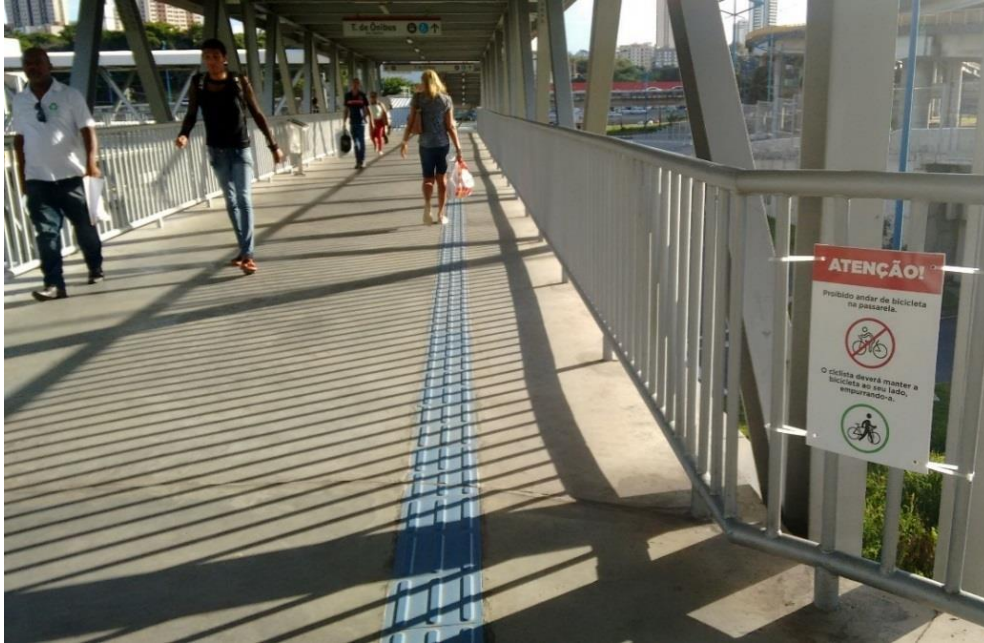
Figura 94 - Passarela de Acesso à Estação Acesso Norte
